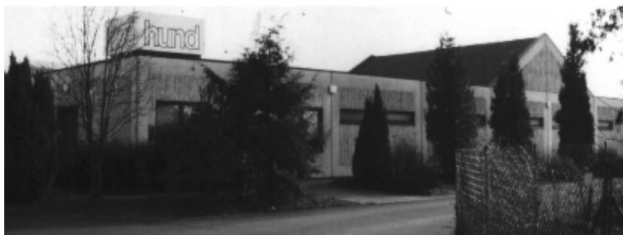
Figura 2.2: Edificio di Verolum, situato a Schöffengrund-Schwalbach (in Germania), riscaldato con un impianto GSHP dal 1980 (foto del 1995) [Sanner, 2001]
